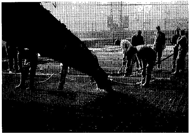
De aan de onderkant van de brug verrijdbaar bevestigde trechter brengt het beton in het vloerveld
